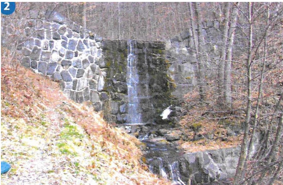
RTM73 04/2006 Grand Barrage du hameau des Teppes
